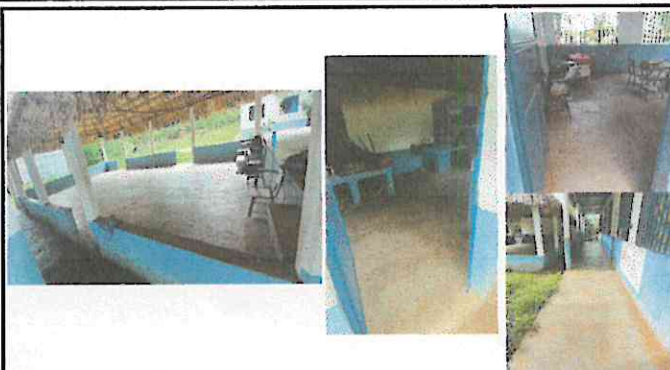
Foto 2: Sustitución de piso de concreto líquido por piso cerámico antideslizante en área de aulas 1,2,3, área de rancho, área de corredor y cocina
