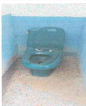
Foto 3: Sustitución del servicio sanitario.
